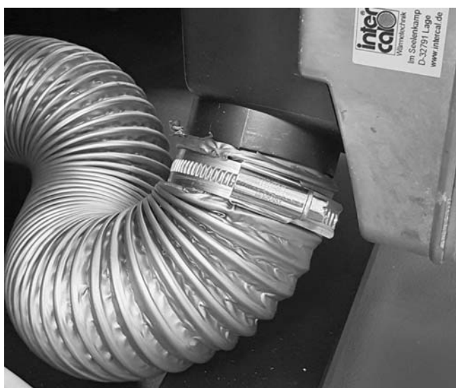
Abb. 14: Zuluftschlauch mit 50 mm Anschluss-Stück
