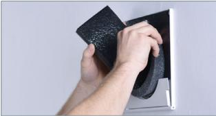
Legen Sie die Schalldämmmatte umlaufend mit einem Abstand von mind. 3 cm zur Ventilatoreinheit raumseitig ein.
