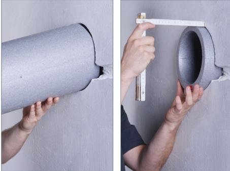
Schieben Sie die Wanddurchführung in den Wanddurchbruch ein und lassen Sie die Wanddurchführung bei Bedarf (z. B. für weitere Putz- oder Dämmschichten) entsprechend raum- und fassadenseitig überstehen. Beachten Sie das **Gefälle nach außen** bzw. die **raumseitige Markierung** der Wanddurchführung.
