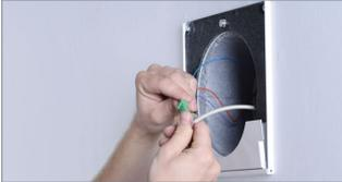
Verbinden Sie anschließend die Steckverbindung der Anschlussleitung zur **EventAir Regelung**.
