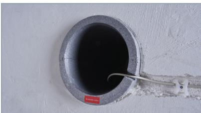
Führen Sie die Anschlussleitung (mind. 3 x 0,60 mm<sup>2</sup>) seitlich (Ansicht Raumseite) in die Wanddurchführung ein. Lassen Sie die Anschlussleitung in **Länge der Wanddurchführung** über stehen.
