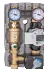
Installationsbeispiel gemischter Heizkreis
