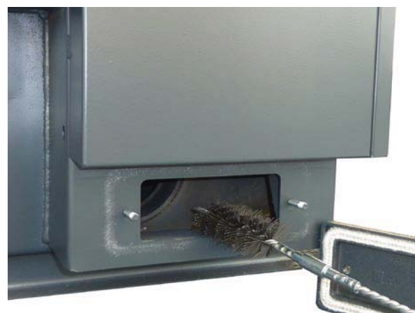
Vorführung der Reinigung des Rauchkanals mit Drahtbürste.
